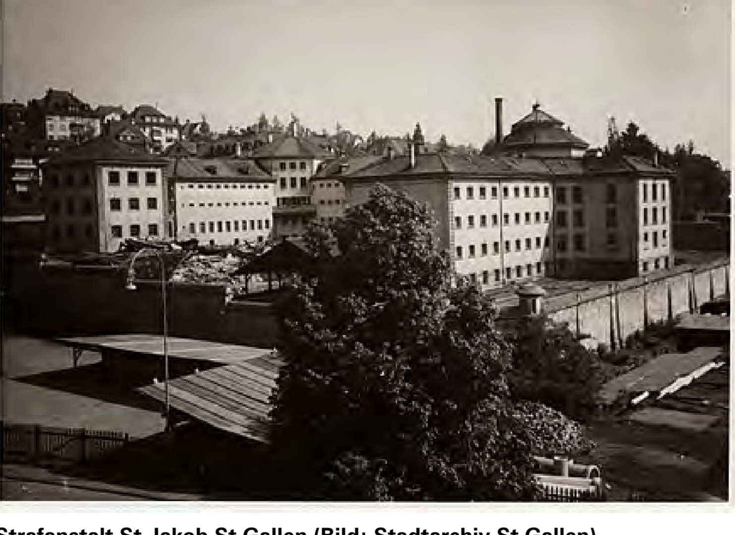
Strafanstalt St.Jakob St.Gallen (Bild: Stadtarchiv St.Gallen)
